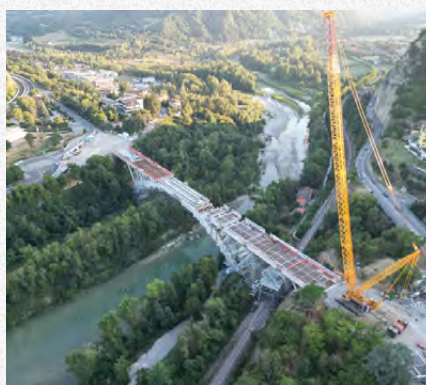
Leonardo da Vinci Bridge, Sasso Marconi, Italy
